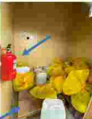
Ruang TPS B3 Sesudah di lengkapi persyaratan sesuai Peraturan Pemerintah Nomor 22 Tahun 2021 (Penambahan APAR, Penerangan, Pemasangan Pallet)
